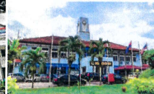
マレー支部 時計塔事務所
