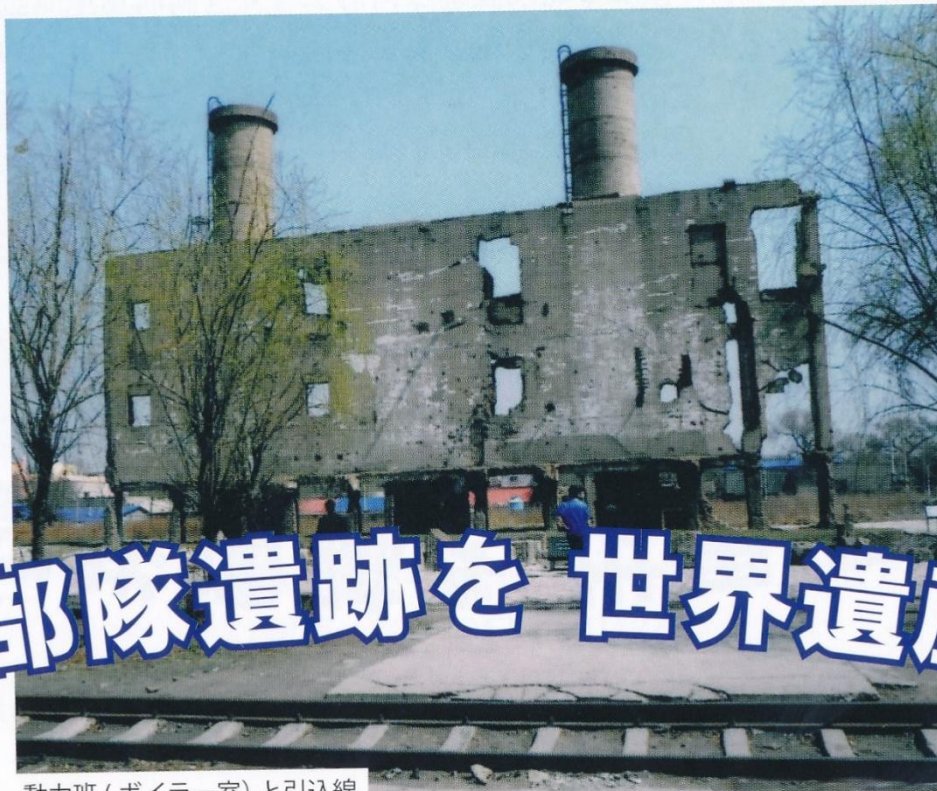
動力班 (ボイラー室) と引込線
